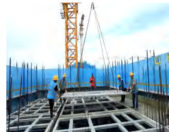
叠合楼板吊装
