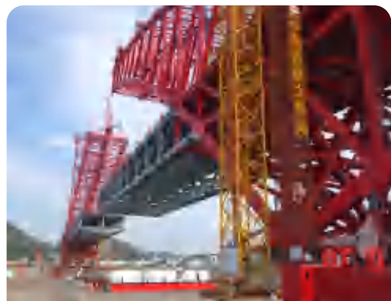
桥梁钢桁梁架设
