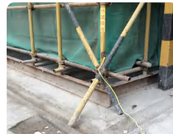
外架基础及防雷接地
