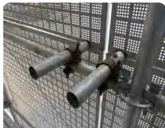
盘扣脚手架封板连接
