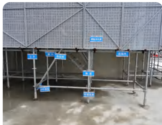
盘扣脚手架基础
