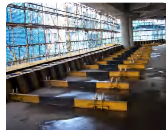
悬挑工字钢锚固
