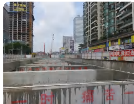
基坑冠梁支撑及喷淋系统
