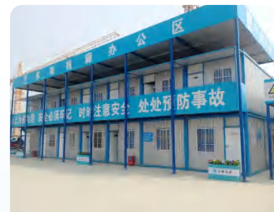
现场办公区防护
