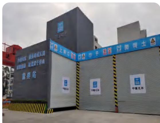
全封闭搅拌站
