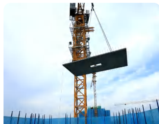
叠合楼板吊装
