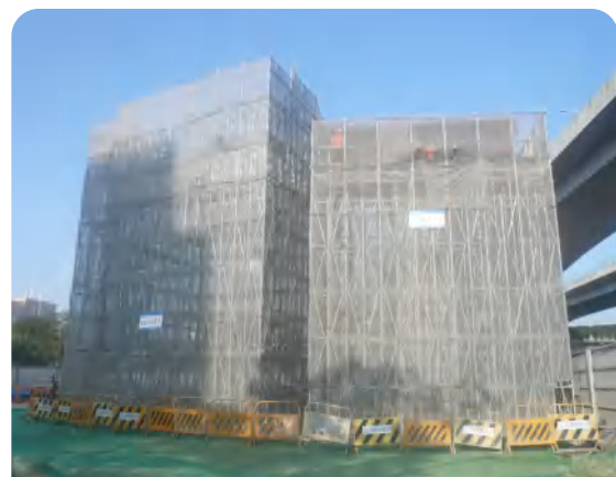
桥墩作业外脚手架
