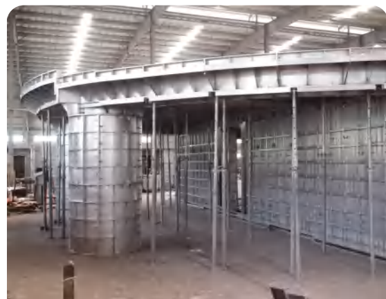
柱体模板支撑
