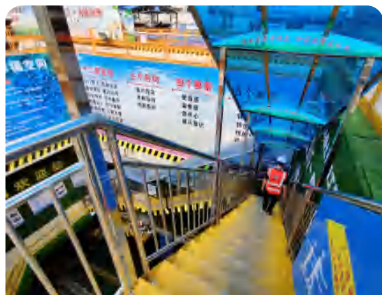
隧道上下步梯人行道
