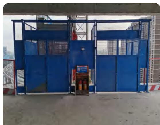
施工梯层门两侧防护
