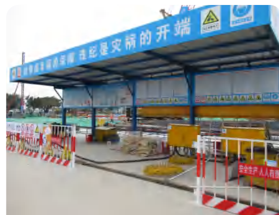
钢筋加工区防护
