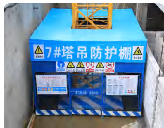
塔吊首层防护
