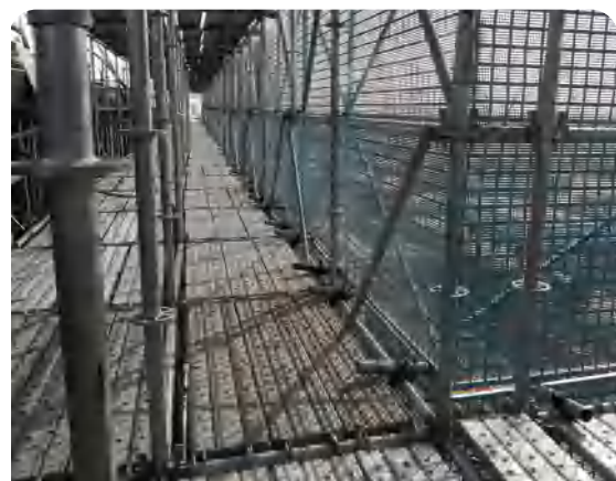
盘扣脚手架走道
