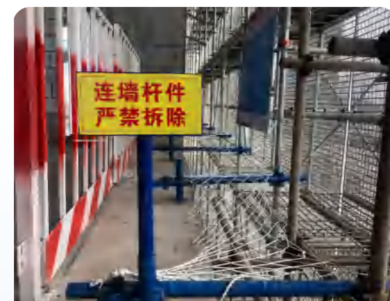
盘扣脚手架连墙件
