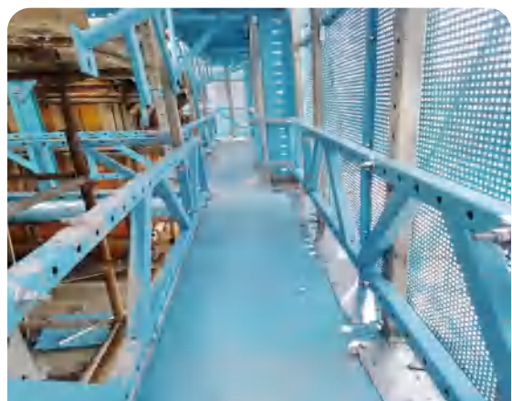
首层走道及双侧水平桁架
