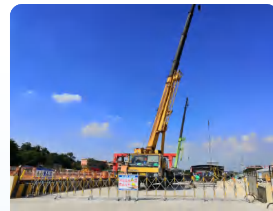
吊装作业警戒
