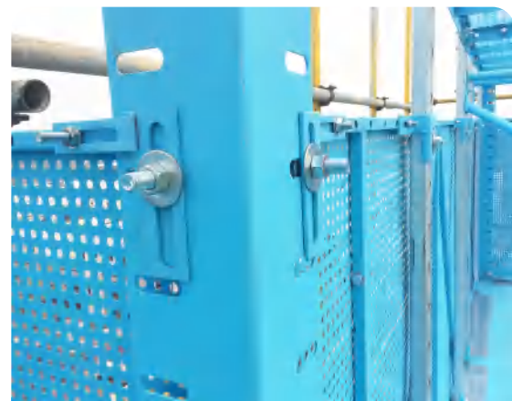
防护网阳角连接
