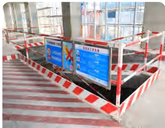
楼梯口临边防护
