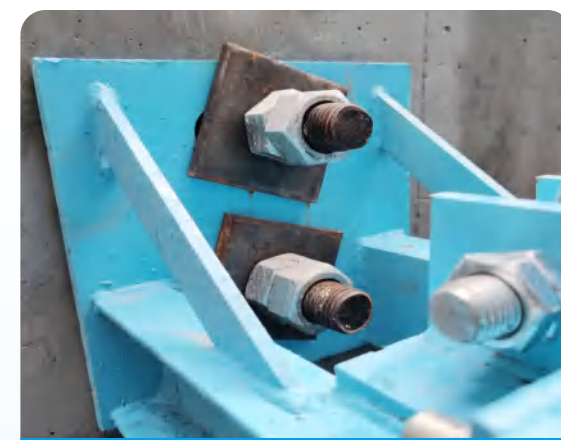
附墙支座安装
